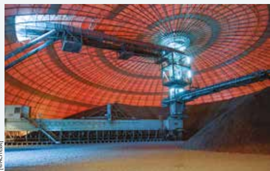
La norme ciment NF EN 197-1 est contraignante sur le produit final. Mais ne fournit aucune exigence sur les caractéristiques des matières premières du cru... Opération de préparation du cru dans une cimenterie.
